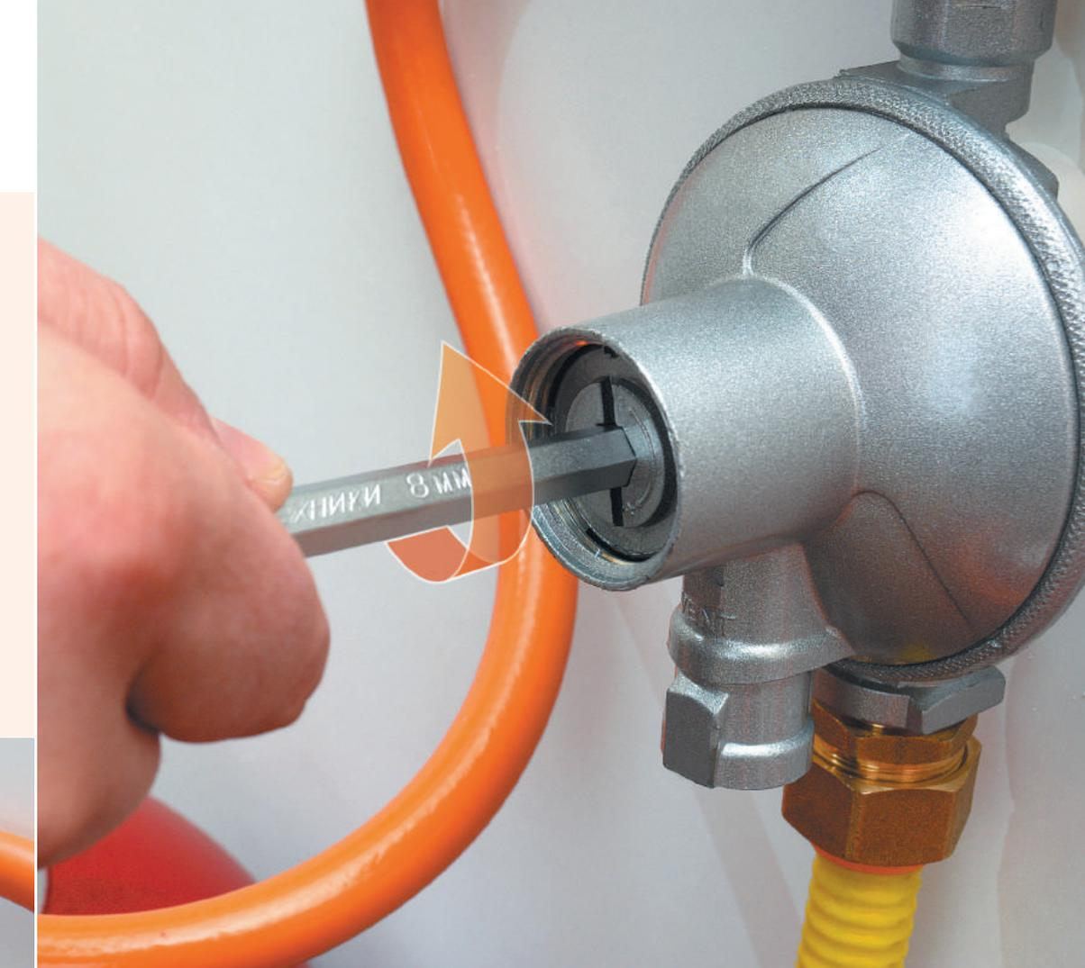
*Газобаллонные системы в базовом варианте имеют специальное оснащение в виде автоматического переключающего клапана, производительность которого 10 кг/час. Этот узел отвечает за первую ступень регулировки давления.*
